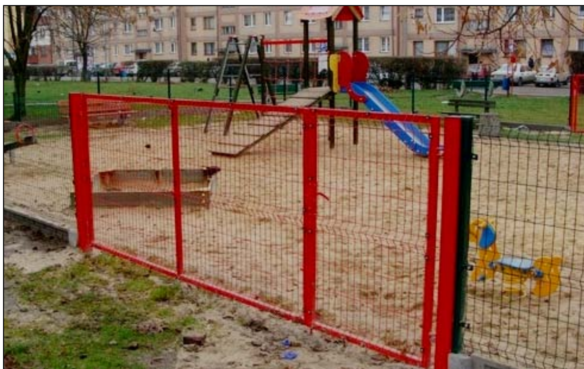
Rys.49 Wejście nr 2 furtka z brama serwisowa z furtką. (skrzydła szerokości 1m (furtka) i 2m (brama), wysokość 1,2m). (na ilustracji w kolorze czerwonym - ma być w kolorze ogrodzenia)
